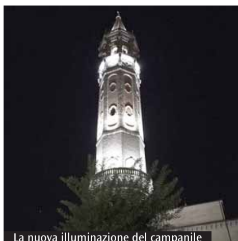
La nuova illuminazione del campanile
