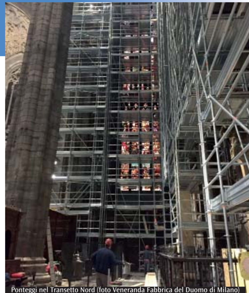
Ponteggi nel Transetto Nord (foto Veneranda Fabbrica del Duomo di Milano)
