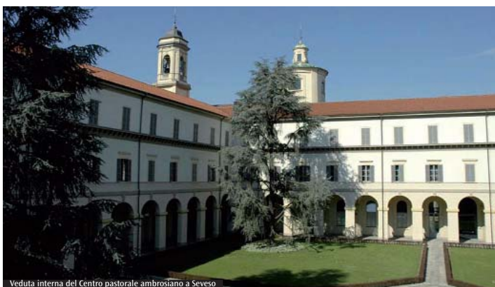
Veduta interna del Centro pastorale ambrosiano a Seveso
