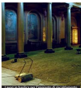
Lavori in basilica per l'impianto di riscaldamento
