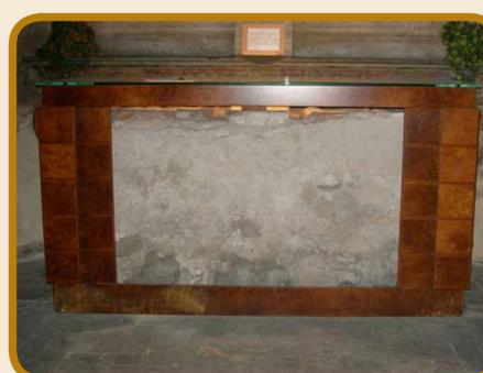
Degrado dell'intonaco della base dell'altare: macchie, efflorescenze saline, polverizzazione, lacune e macchie sulla cornice lignea moderna
