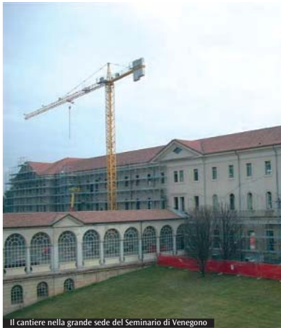
Il cantiere nella grande sede del Seminario di Venegono
