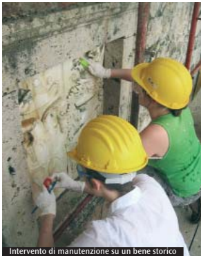
Intervento di manutenzione su un bene storico
