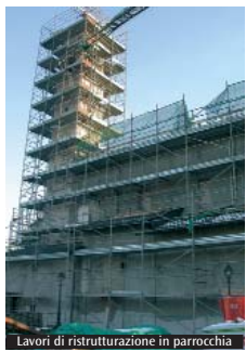
Lavori di ristrutturazione in parrocchia
