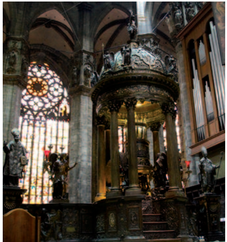
Milano, Duomo: veduta del ciborio dopo il recente intervento di restauro
