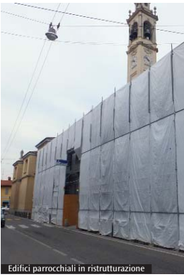
Edifici parrocchiali in ristrutturazione
