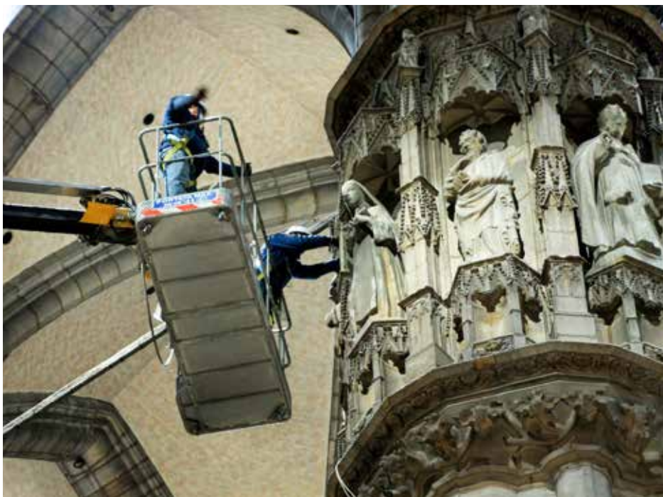
Milano, Duomo: i lavori per il nuovo impianto elettrico
