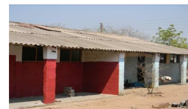
Chipanga-odi in corso di ristrutturazione
